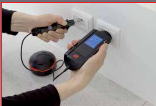
Contrôle de continuité entre prises.
